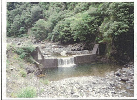
状況写真(取水)
