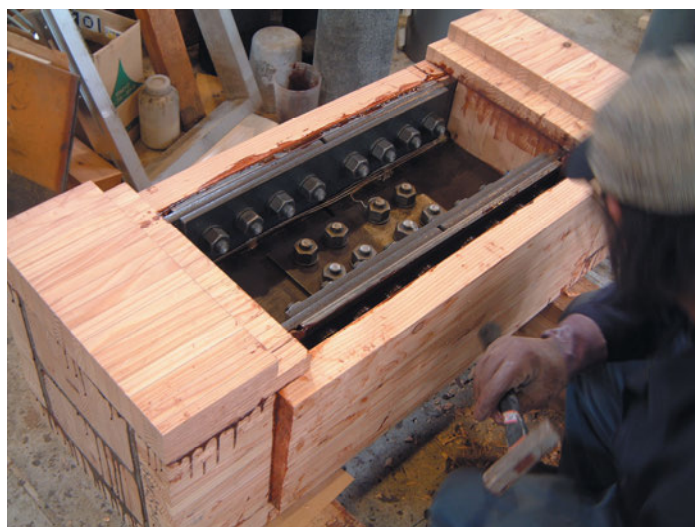
写真-4-1. 接着状況
