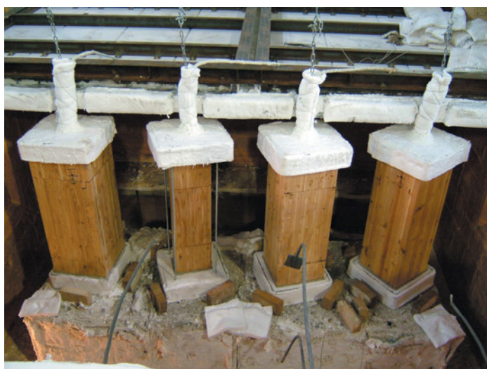
写真-5. 燃焼試験前の状況
