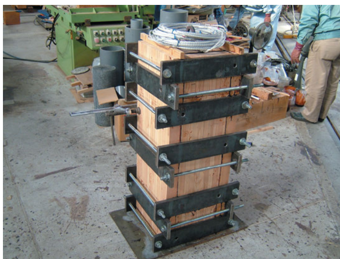
写真-4-2. 接着状況
