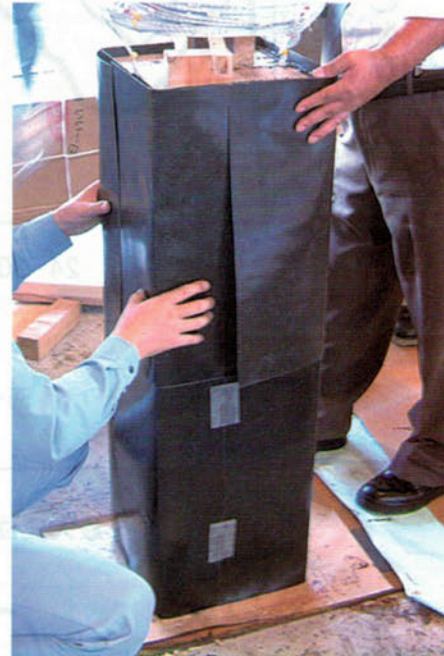
写真-3. 発泡黒鉛シートの貼り付け状況
