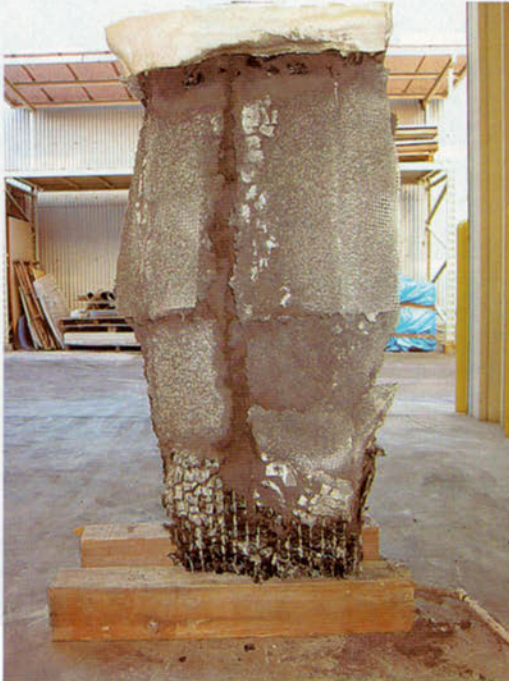
写真-6. No. 2 の試験後の写真
