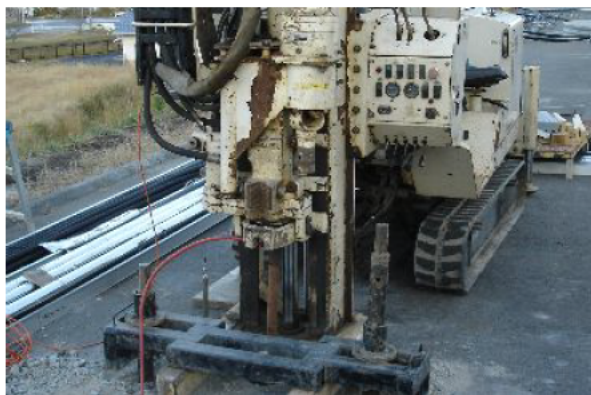
写真1 コーン貫入試験機によるVOC汚染調査。センサーの付いたコーンを貫入し、リアルタイムでVOC成分毎の濃度が測定できます。
