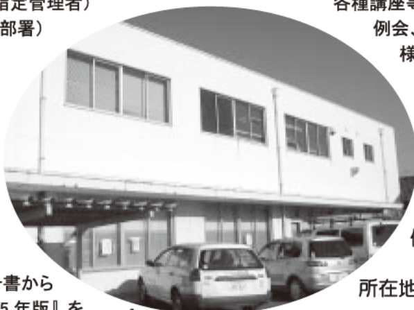
現在改装中の 亀山市民 協働センター
