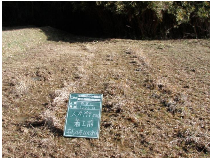
写真 4-3-11 整備状況(除草工(人力)：除草前・ハシヨウブ植栽地：平成 26 年 11 月 28 日)
