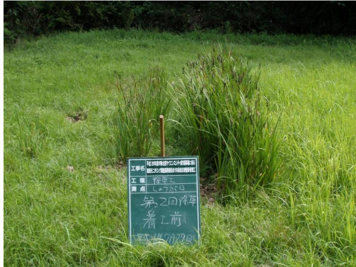
写真 4-3-7 整備状況(除草工(人力)：除草前・ハシヨウブ植栽地：平成 26 年 7 月 29 日)
