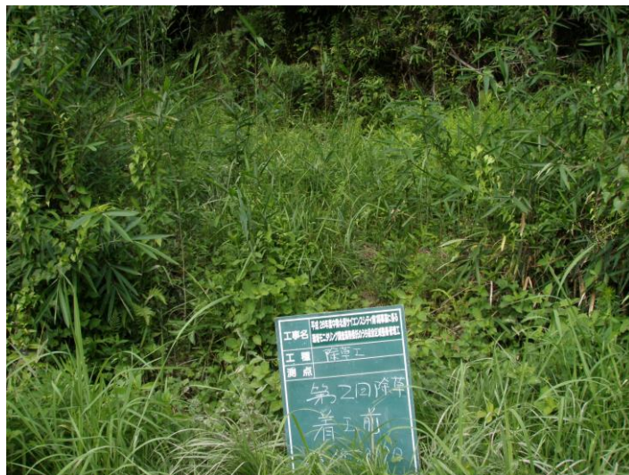
写真 4-3-15 整備状況(除草工：除草前・保全区域A・通路：平成26年7月29日)
