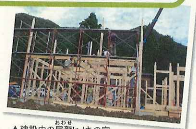
▲建設中の尾鷲ヒノキの家
