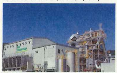
▲木質バイオマスの発電施設
