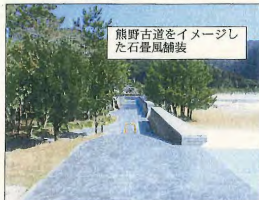
三木里地区（尾鷲市）三木里海岸堤防
