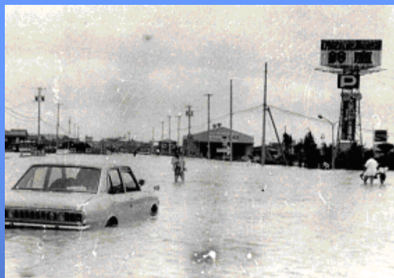
撮影場所：国道23号寺家町 (撮影日S49.7.25)
