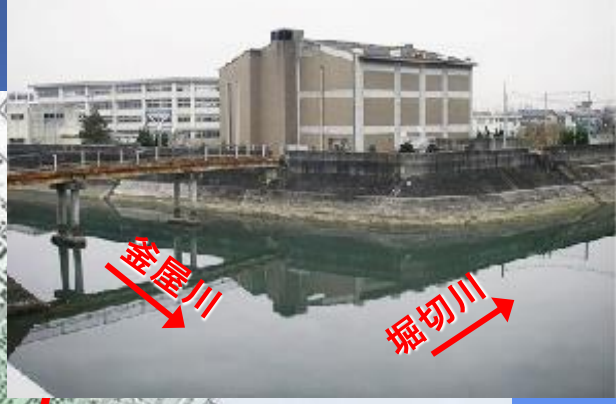
釜屋川合流点、釜屋排水機場
