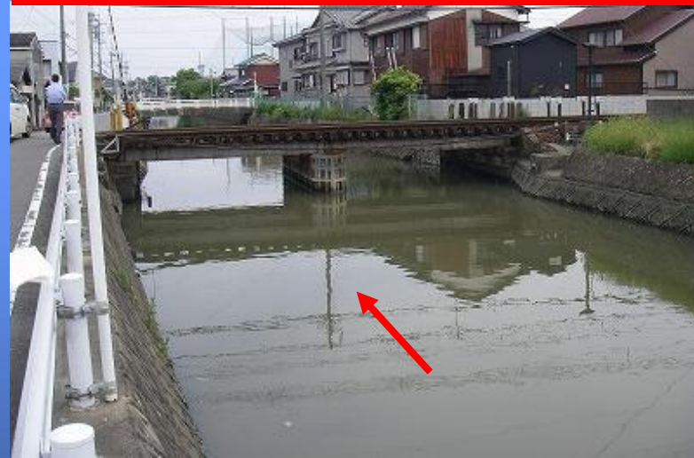
釜屋川(近鉄橋梁)
