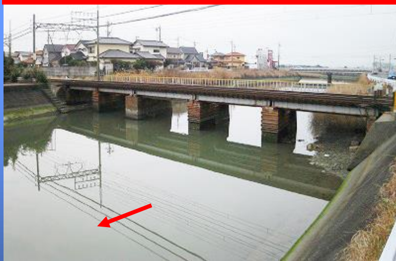
堀切川(近鉄橋梁)
