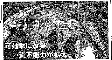
可動堰に改築 → 流下能力が拡大 旧松之木井堰 固定堰を撤去 → 水位低下
