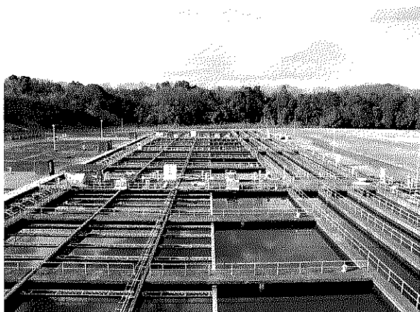
耐震化予定の主要施設 (山村浄水場)
