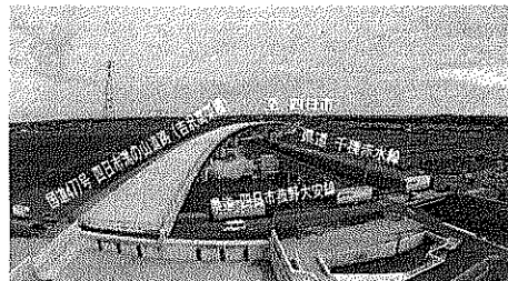
新名神の全線供用に合わせた整備を進めている 国道477号四日市湯の山道路
