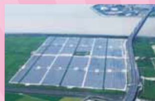
▲木曾岬メガソーラー(株)(49MW)(木曾岬町、桑名市)
