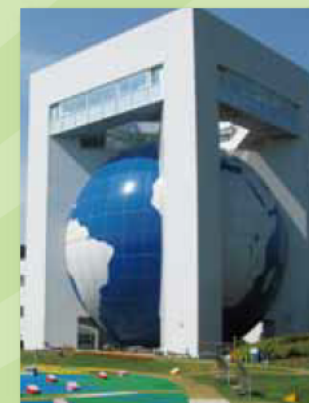
▲中部電力(株)川越電力館テラ46(川越町)
