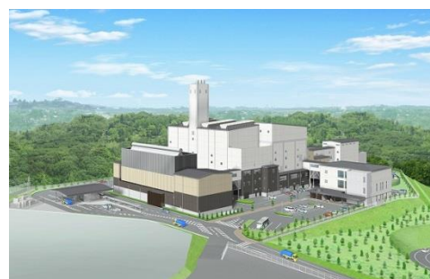
四日市市新総合ごみ処理施設 処理 336t/日（ガス化熔融式） 発電出力 9,000 kW
