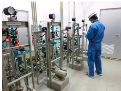
薬品注入設備の点検
