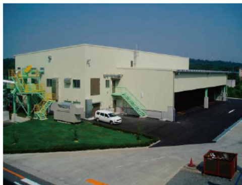
RDF貯蔵施設
