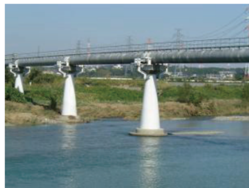
耐震補強後の水管橋
