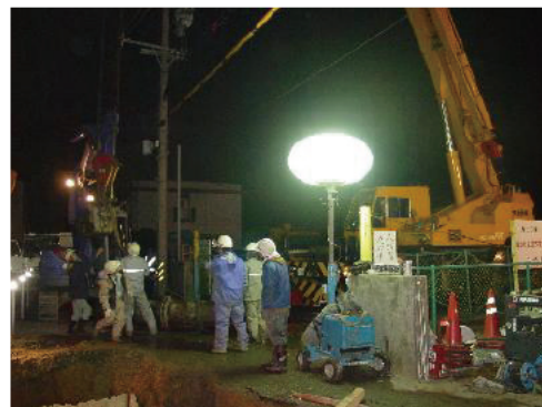
夜間の漏水復旧作業
