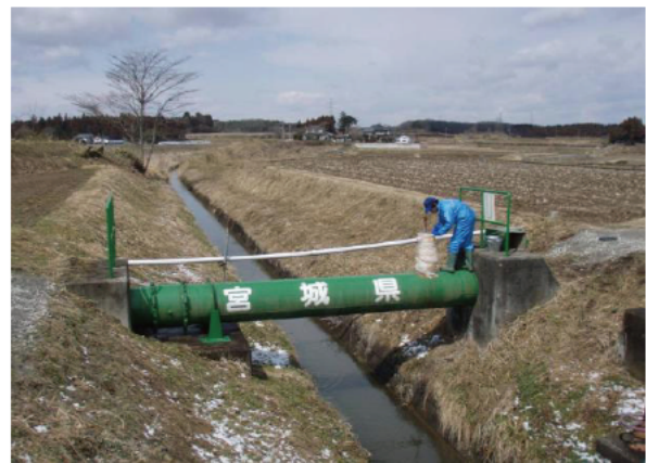
【工業用水道施設・管路の点検】
