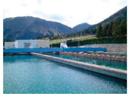
沈でん池(北中勢水道 水沢浄水場)
