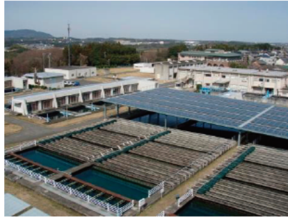
浄水場(北中勢水道 高野浄水場)
