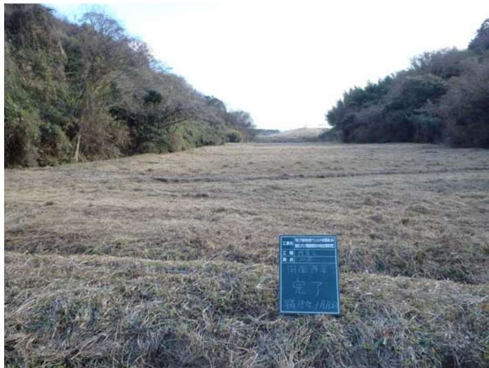
写真 4-3-18 整備状況(除草工：除草後・保全区域 A・放棄水田：平成 28 年 1 月 16 日)
