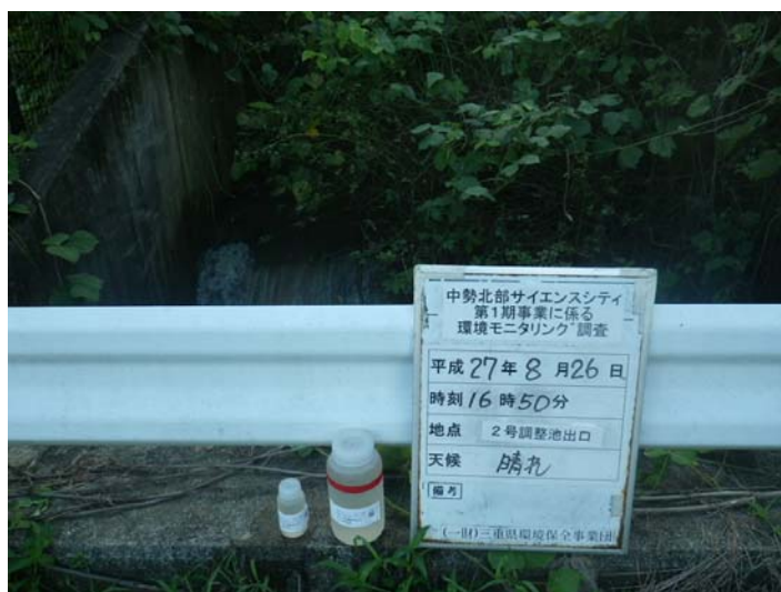
写真 4-1-17 濁水調査状況(豪雨時)(2号調整池出口)(平成 27 年 8 月 26 日)
