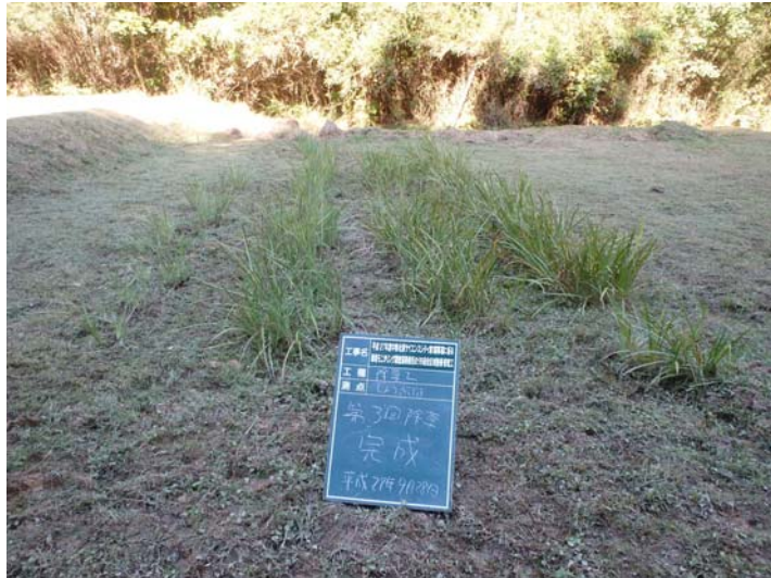
写真 4-3-10 整備状況(除草工(人力)：除草後・ハシヨウ ® 植栽地：平成 27 年 9 月 28 日)
