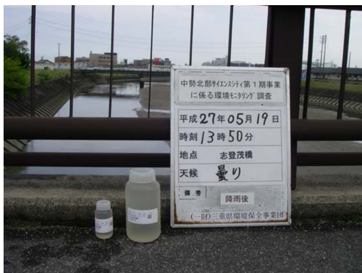
写真 4-1-2 濁水調査状況(通常降雨時)(志登茂橋)(平成 27 年 5 月 19 日)
