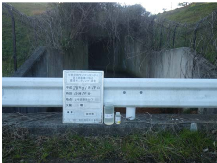
写真 4-1-45 濁水調査状況(通常降雨時)(2号調整池出口)(平成 28 年 1 月 19 日)
