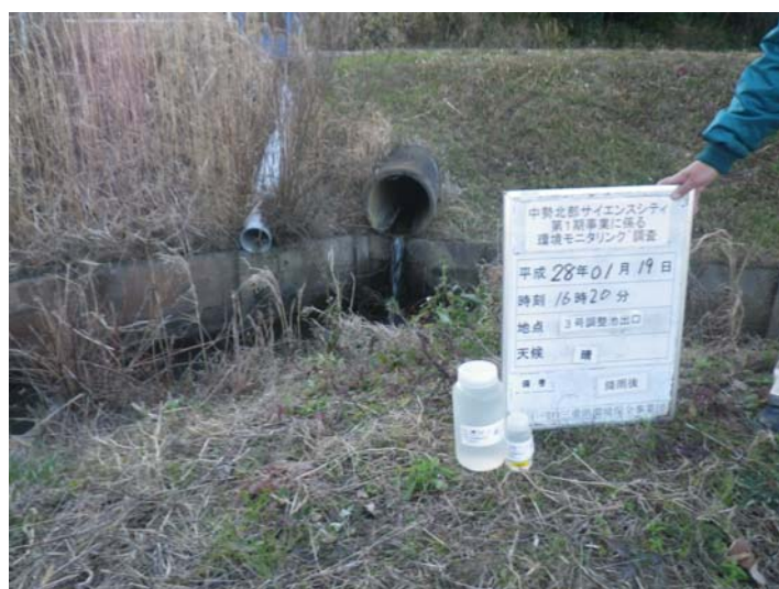
写真 4-1-47 濁水調査状況(通常降雨時)(3号調整池出口付近)(平成 28 年 1 月 19 日)
