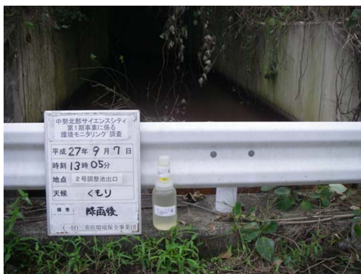
写真 4-1-21 濁水調査状況(通常降雨時)(2号調整池出口)(平成27年9月7日)
