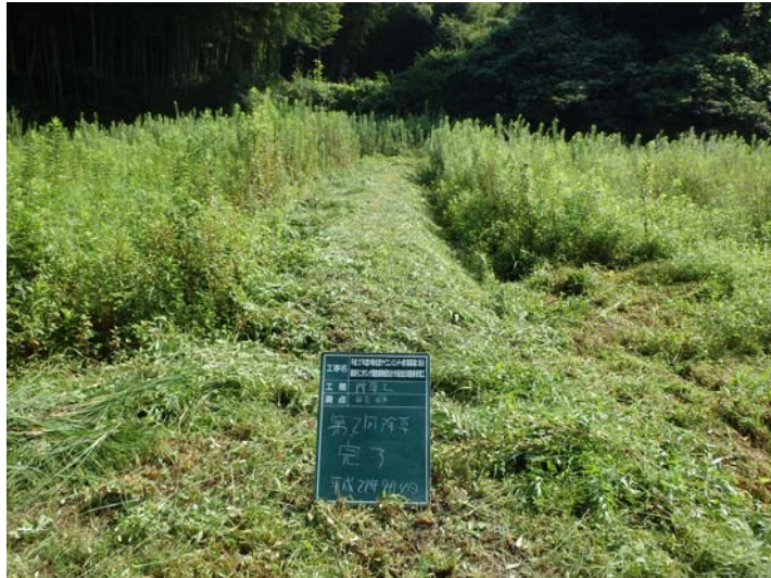
写真 4-3-4 整備状況(除草工(機械)：除草後・保全区域A・畦畔等：平成 27 年 9 月 4 日)
