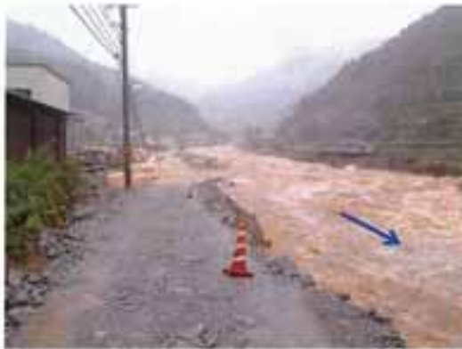
二級河川井戸川（熊野市）の復旧状況
