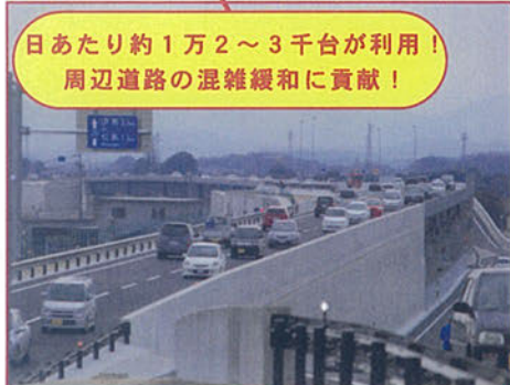
H24.2.5 供用区間の状況
