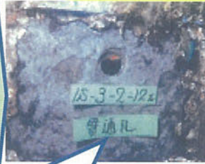
貫通孔があり、補強が必要な鋼管杭
