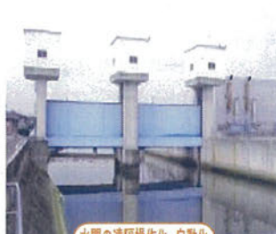
水門の遠隔操作化、自動化
