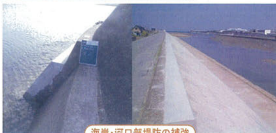
海岸・河口部堤防の補強
