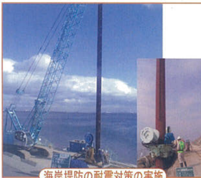
海岸堤防の耐震対策の実施
