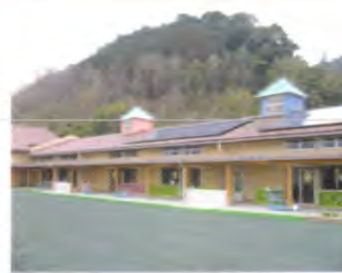
木造公共施設の整備(多気町)
