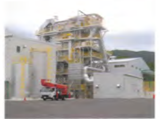
木質バイオマス発電所の整備(松阪市)
