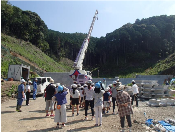
工事中の現場見学
