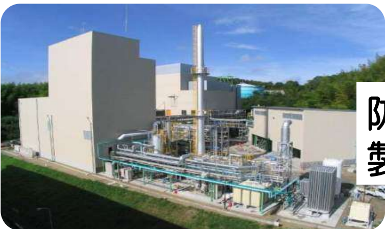
株式会社クリーンステージ 大阪府和泉市 95t/日(24h)(ガス化溶融炉)
