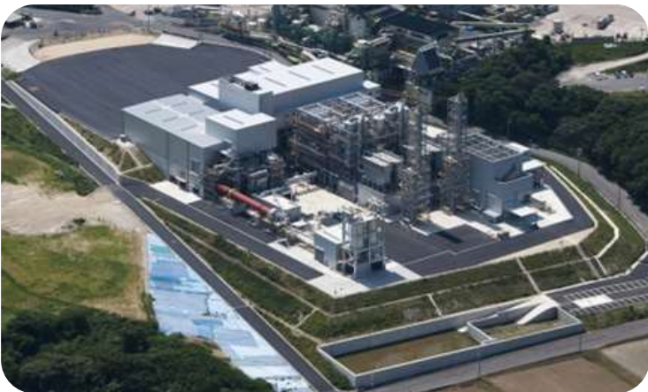
三重中央開発(株):三重県伊賀市 130t/日(24h) 318t/日(24h)×2基
