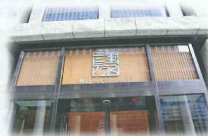
三重テラス 外観
