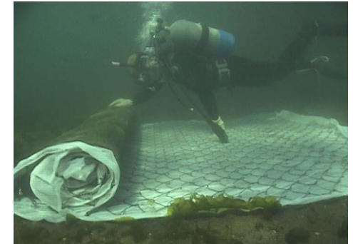
② ダイバーによるマットの設置
