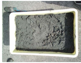
② 玉砂利の上に調整した砂泥（砂：泥＝7：3）を敷く（約7cm）
