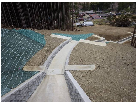
治山事業 復旧状況(熊野市)
