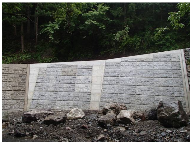
林道高代山・大井川線 復旧状況（熊野市）
