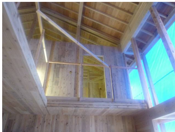
CLTを使用した国内初の住宅の建築
