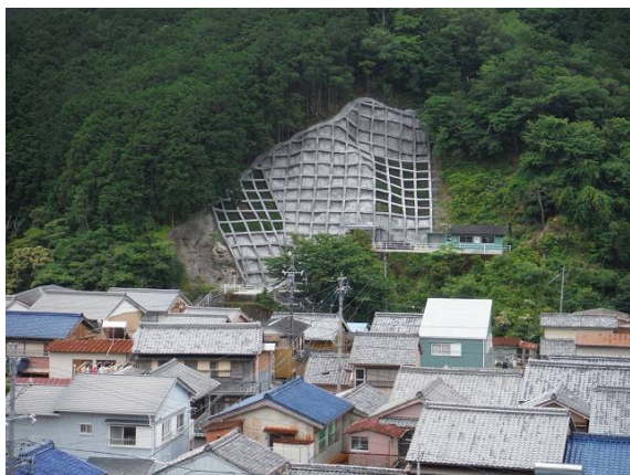
治山事業 復旧状況(大紀町)
