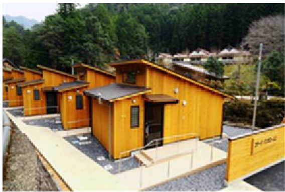
木造公共施設 (湯ノ口温泉バンガロー：熊野市)
