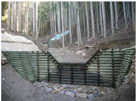
公共工事等の利用事例 床固工(松阪市)
