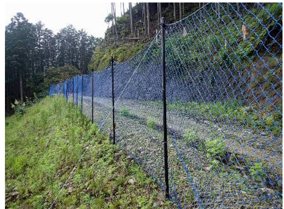
植栽地への防護柵の設置（松阪市）
