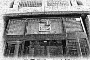
三重テラス 外観
