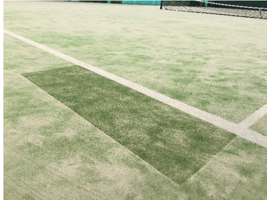
段差が生じているテニスコート
