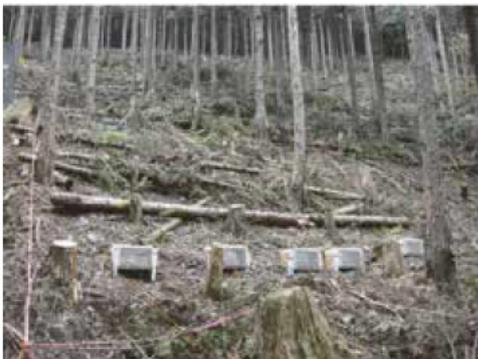
図-1. 伐倒木を横並べした土砂止
