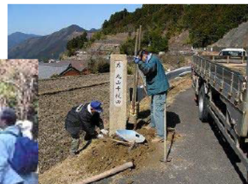
石道標を設置している様子
