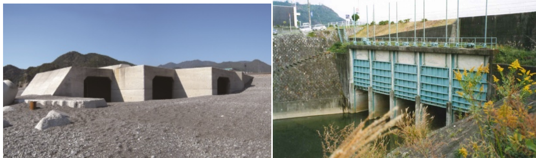
図 4-3 井戸川樋門 1 号
