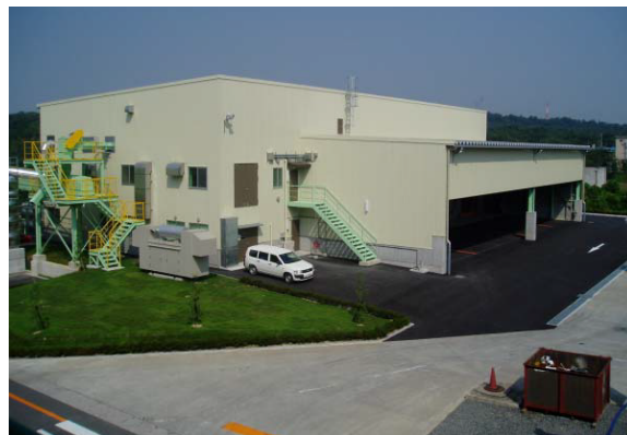
RDF貯蔵施設
