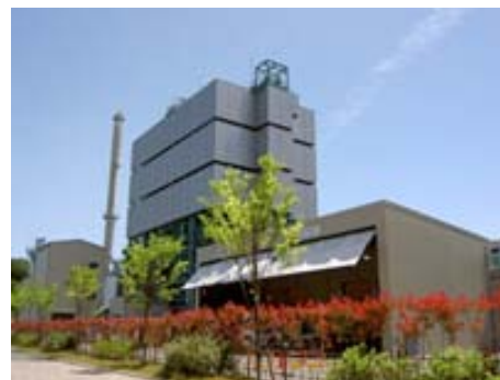
RDF焼却・発電施設
