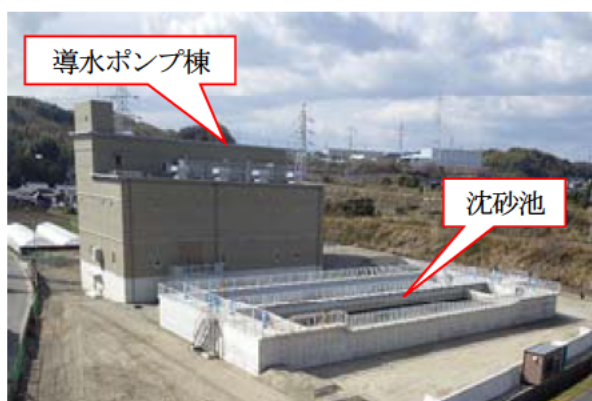
耐震補強工事が完了した野代導水ポンプ所 (平成28年度完了)
