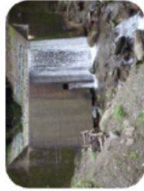
治山施設の長寿命化対策(基礎部の補強)
