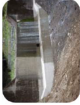
治山施設の長寿命化対策(基礎部の補強)
