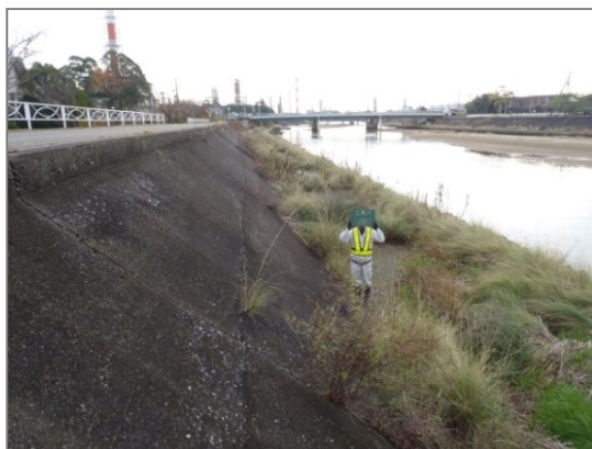
堤防点検状況
