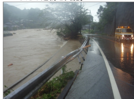
出水時巡視状況
