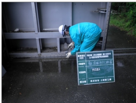
水門等点検状況
