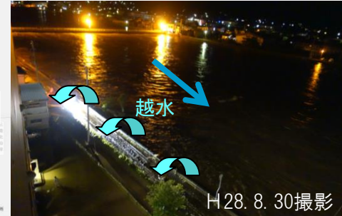
久慈川(右岸)越水状況
