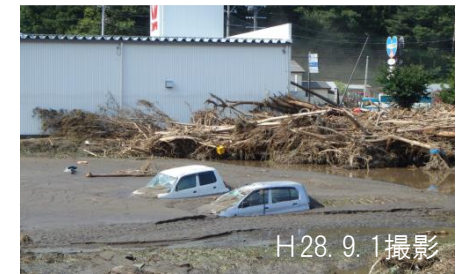
小本川 被害状況②
