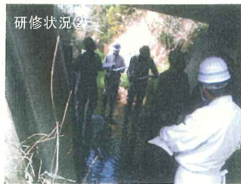
桁下より橋台、床版等を点検
