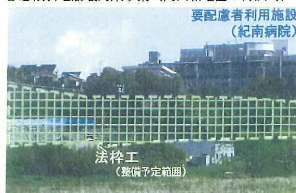
●急傾斜地崩壊対策事業（阿田和地区：御浜町）
