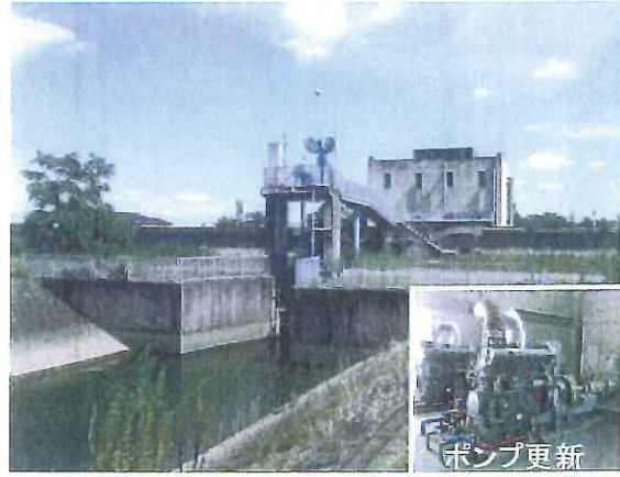
【鍋田川上流排水機場】排水機場のポンプ 更新（桑名郡木曾岬町加路戸）
