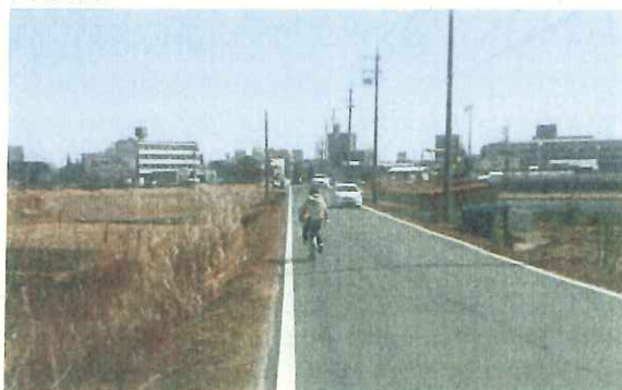
歩道がなく、歩行者等が危険な状態である
