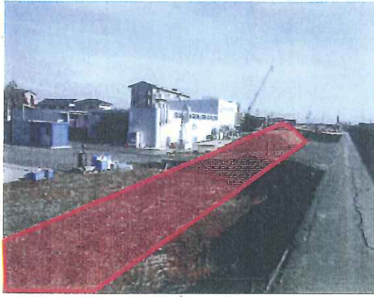
【堀坂川】 堆積土砂撤去（松阪市曲町地先）
