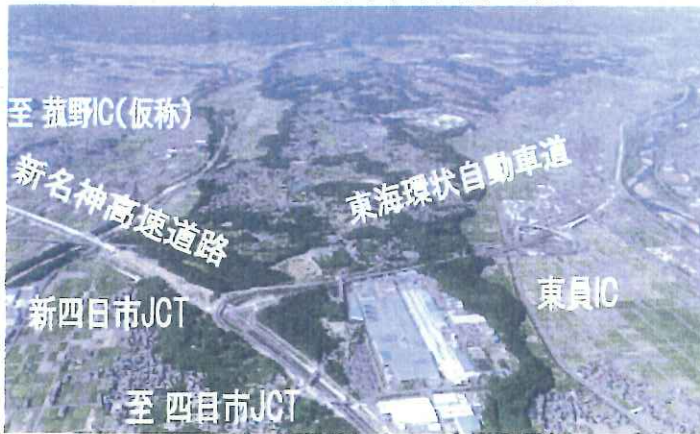
①新名神高速道路・東海環状自動車道 (東員町長深地内)
