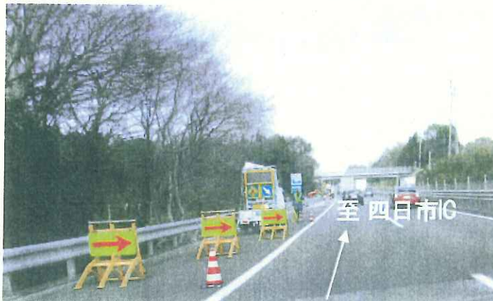
②東名阪自動車道 (四日市市桜地内)
