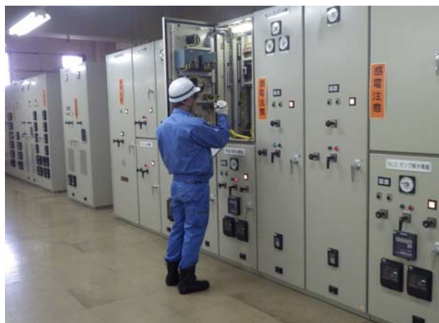
電気設備盤内の保守点検状況
