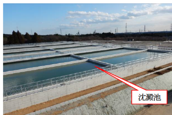
耐震補強工事が完了した沢地浄水場 (平成27年度完了)
