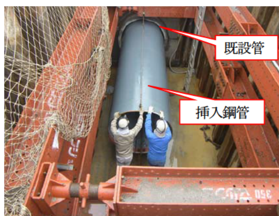
PIP工法による既設管への鋼管挿入状況 (内径1000mm 1000mm PC管布設替)
