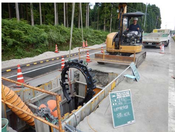
既設管路の継手部への耐震補強金具取付状況
