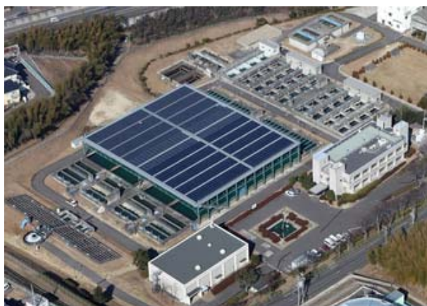
太陽光発電設備（播磨浄水場）
