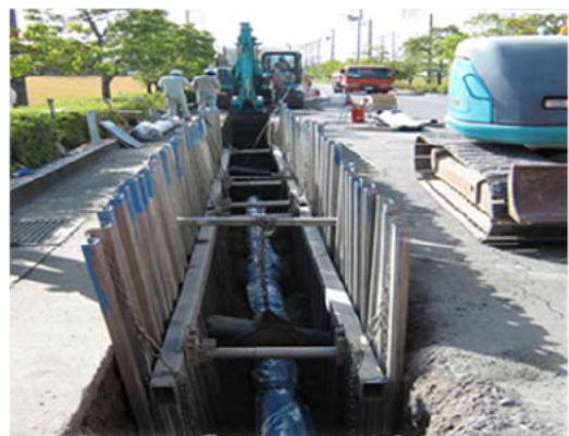
管路布設替えの状況
