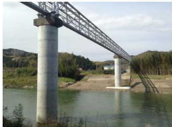
櫛田川水管橋下部工の耐震化
