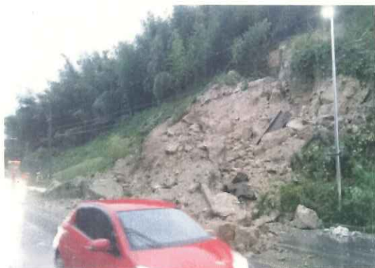
一般国道 421 号 被災状況
