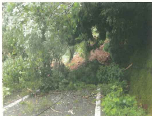
一般国道 169 号 被災状況
