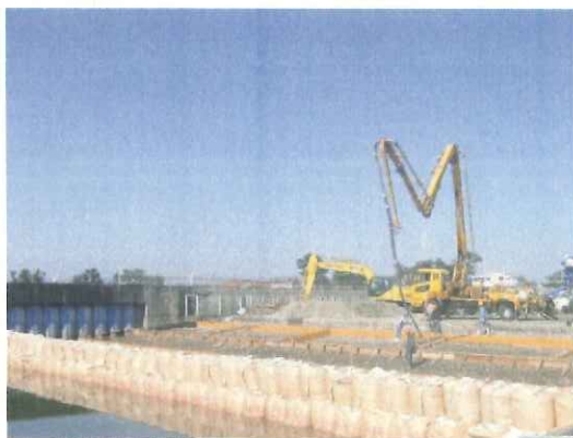
重要港湾 津松阪港 (津市)
