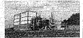
木質バイオマス発電所 多気バイオパワー
