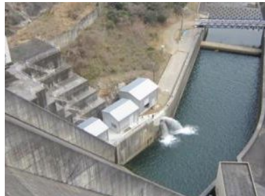
発電稼働状況
