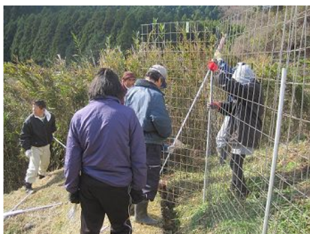
共同での獣害柵設置
