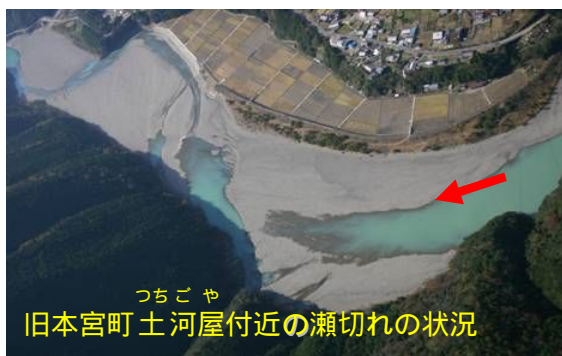
写真1 瀬切れ状況写真(H16.11.29)
