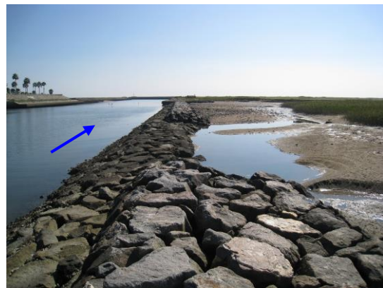
図 2.9 空石積による護岸整備
