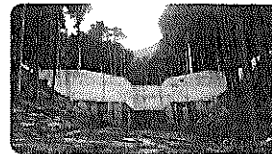
治山施設の機能強化対策 (堰堤の嵩上げ)
