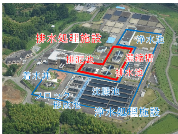
排水処理施設
