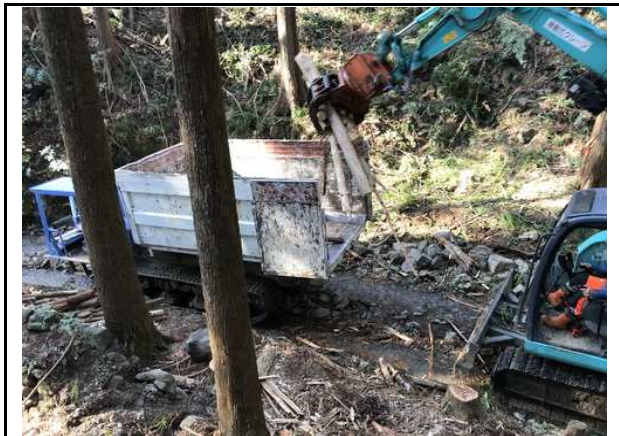
写真12 十須地区【実施中】 集材作業中
