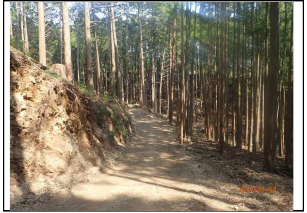
写真14 十須地区【実施後】 作業道設置後
