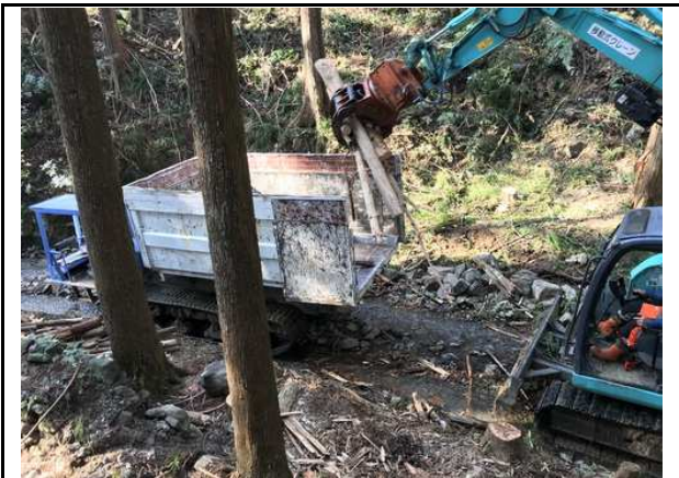
写真11 十須地区【実施中】 集材作業中
