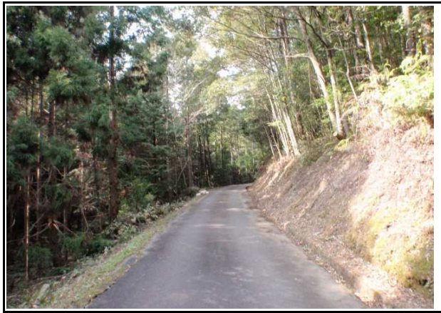
写真2 事業実施後(林道に覆いかぶさる危険木伐採後や枝下ろし後)
