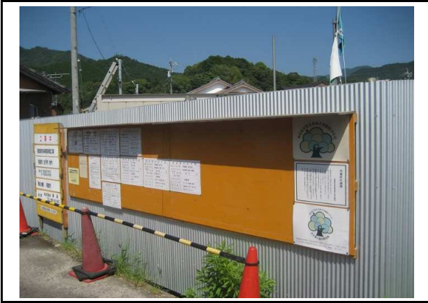
写真1 工事中 囲い等に周知看板を設置した。
