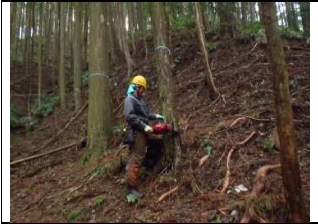
写真7 十須地区【実施中】 伐採作業
