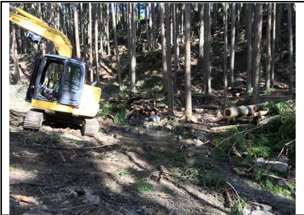
写真9 十須地区【実施中】 集材作業中
