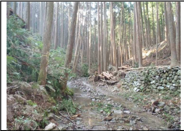
写真3 十須地区【実施前】 往古川沿いで土砂の堆積により、立ち枯れが発生している。
