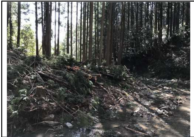
写真10 十須地区【実施中】 集材作業中
