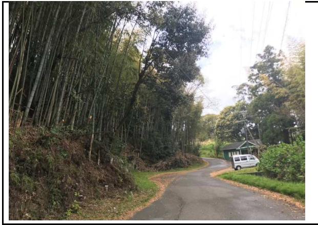
写真2 危険木伐採後(町道北上野線)
