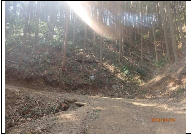
写真13 十須地区【実施後】 作業道設置後
