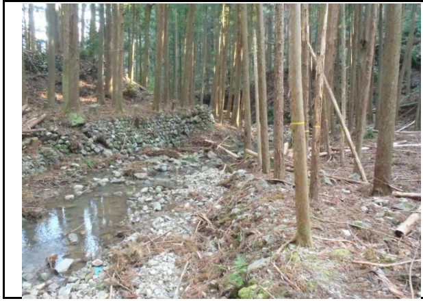
写真2 十須地区【実施前】 往古川沿いで土砂の堆積により、立ち枯れが発生している。
