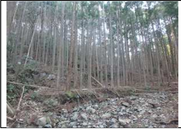
写真1 十須地区【実施前】 往古川沿いで土砂の堆積により、立ち枯れが発生している。
