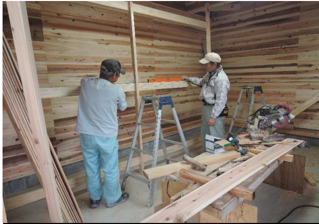
写真2 飯盛地区自主防災会による施工状況
