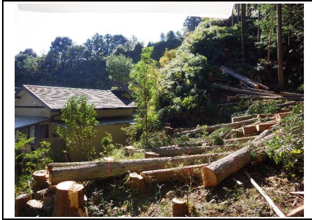
写真2 実施後(倉ノ谷地区)
