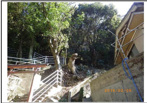
写真4 実施後(梶賀地区)
