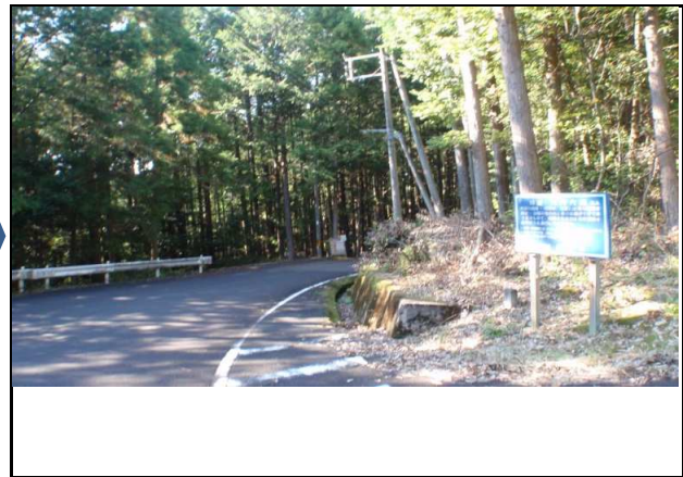
写真4 伐採後(大河内線)
