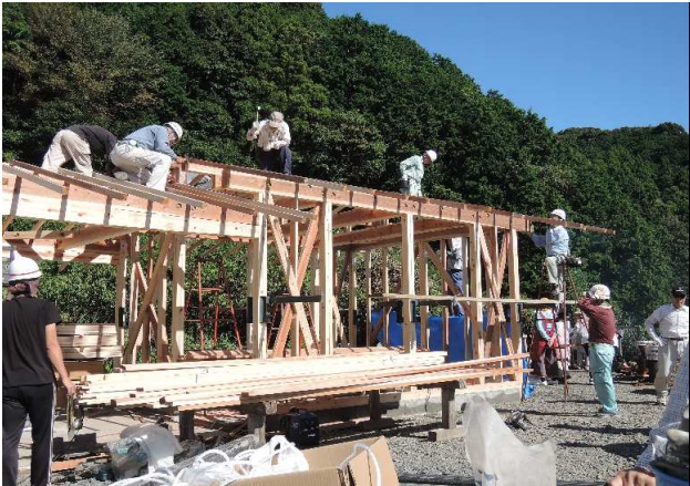
写真1 飯盛地区自主防災会による施工状況
