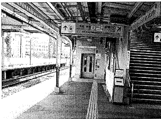
鉄道駅に設置されている エレベーター (伊勢市駅)
