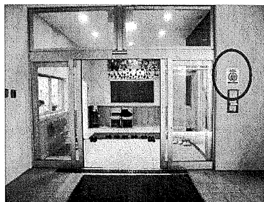
整備基準適合証プレート が設置されている施設
