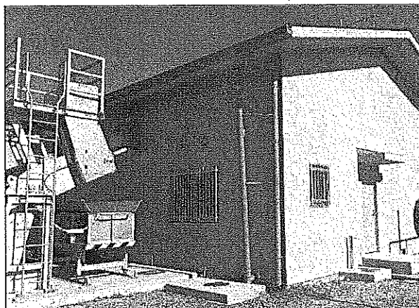
新設された阿児排水機場
