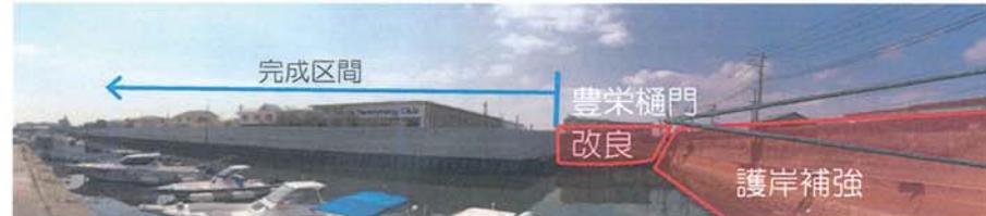
○築後50年が経過し、耐震基準を満たさない状況のため護岸補強を実施
