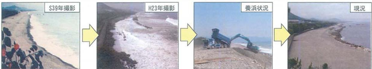
熊野川直轄河川改修事業による掘削土砂を大規模に投入することにより、海浜が安定しています。
