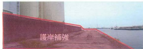
○津波・高潮による海水の侵入が懸念され、耐震対策を踏まえた護岸補強に着手
