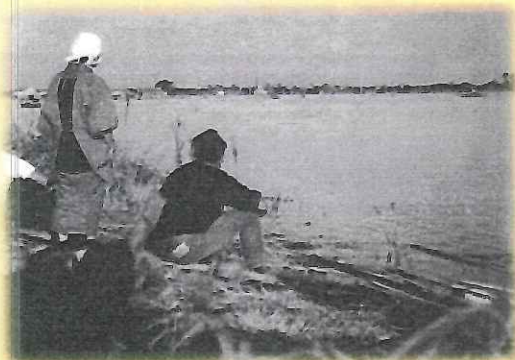
伊勢湾台風の被害(輪中の郷提供)
