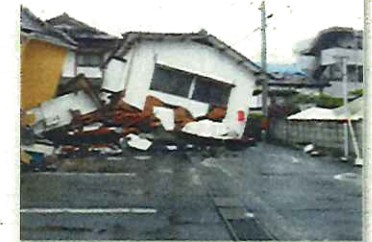
倒壊して道路をふさぐ建築物(熊本地震)
