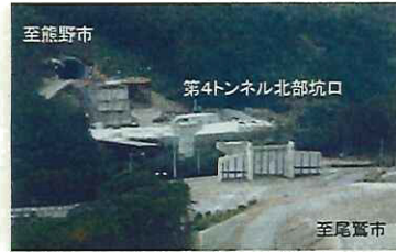
早期完成に向けて工事の最盛期を迎える熊野尾鷲道路(Ⅱ期)
