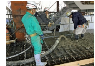
【圧送ポンプを利用して型枠内にコンクリートを打ち込むところ】
