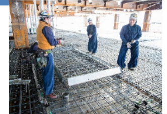
【鋼製型枠を鉄筋上に取付している作業風景（左が外国人材）】
