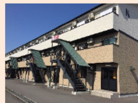
新設した外国人専用の寮 (外観)
