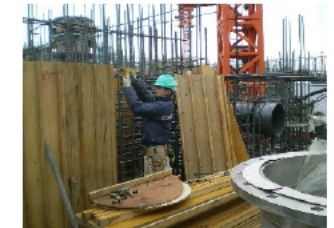
【コンクリートを流し込むための型枠を組む作業の様子】
