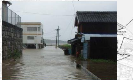
【中島地区】 ・無堤部の溢水による家屋浸水
