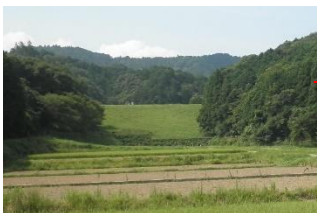
汁谷池（ため池）
