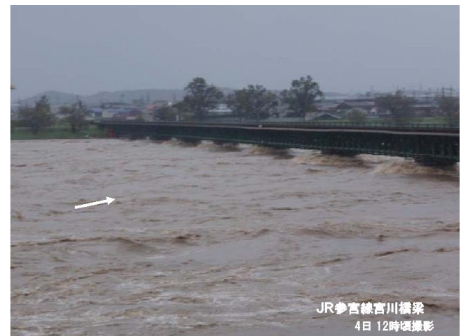
宮川の水位状況(JR参宮線宮川橋梁)
