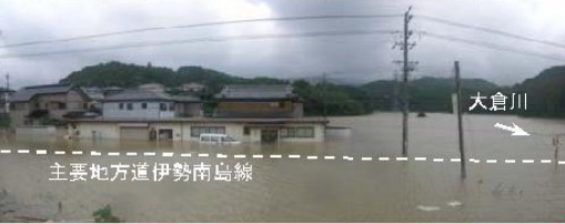
【大倉川流末】 ・内水による 家屋浸水、道路冠水、田畑冠水
