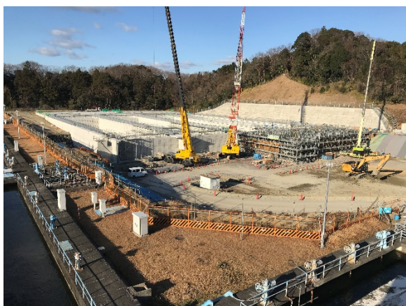
山村浄水場耐震補強工事施工状況
