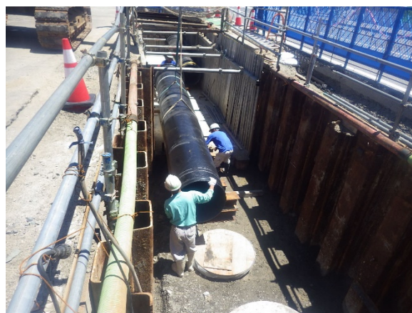
配水管布設替工事施工状況
